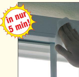
Klebeuntergrund mit beigefügtem Spezialreiniger abwischen
