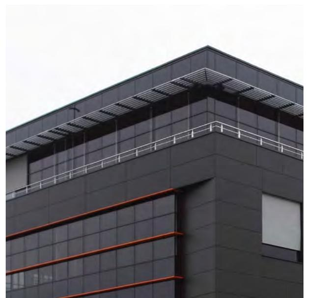
Die maximalen Abmaße des Systems **Sunbreaker** betragen 4000 mm (Breite) x 6020 mm (Höhe). Das System ist modular kombinierbar.
