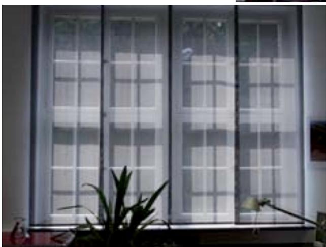
Das Material der frei verschiebbaren Paneele reflektiert bis zu 95 Prozent der einfallenden Sonnenenergie.
